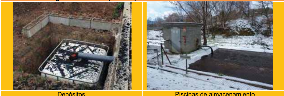
Figura 7.10: Otras opciones para almacenamiento de lixiviados
