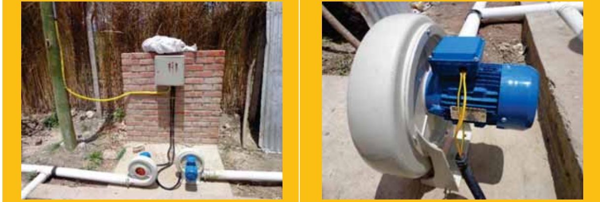
Figura 7.15: Instalación de ventiladores
