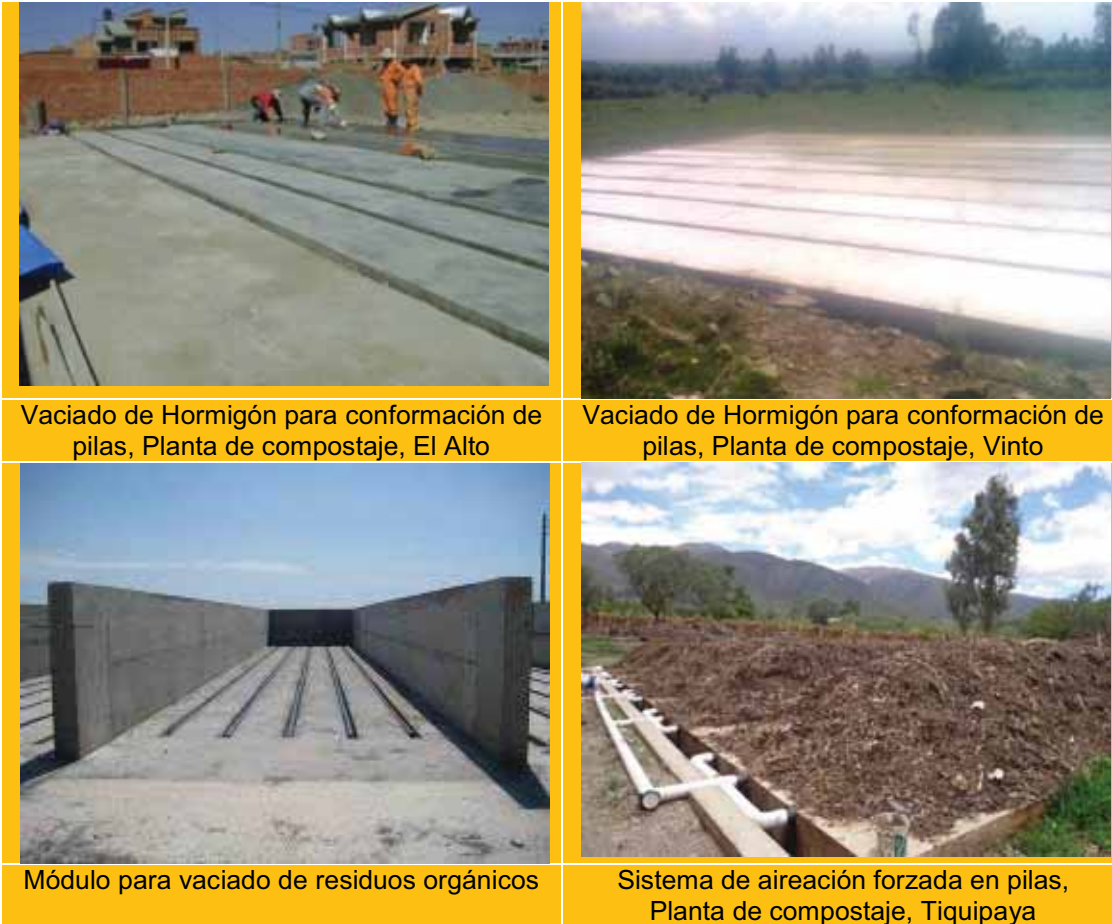
Figura 5.3: Sistemas de aireación forzada
