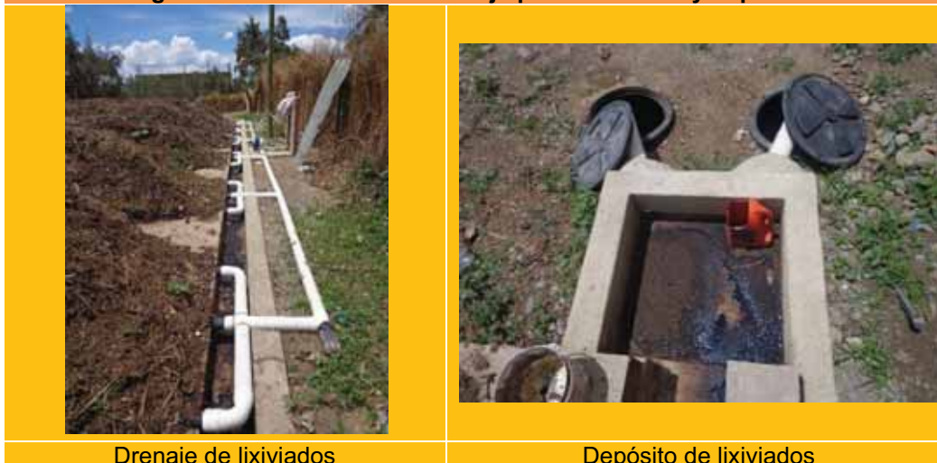
Figura 7.9: Instalación de drenaje para lixiviados y depósitos
