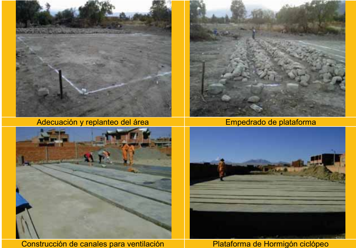
Figura 7.12: Construcción de la plataforma para conformación de pilas
